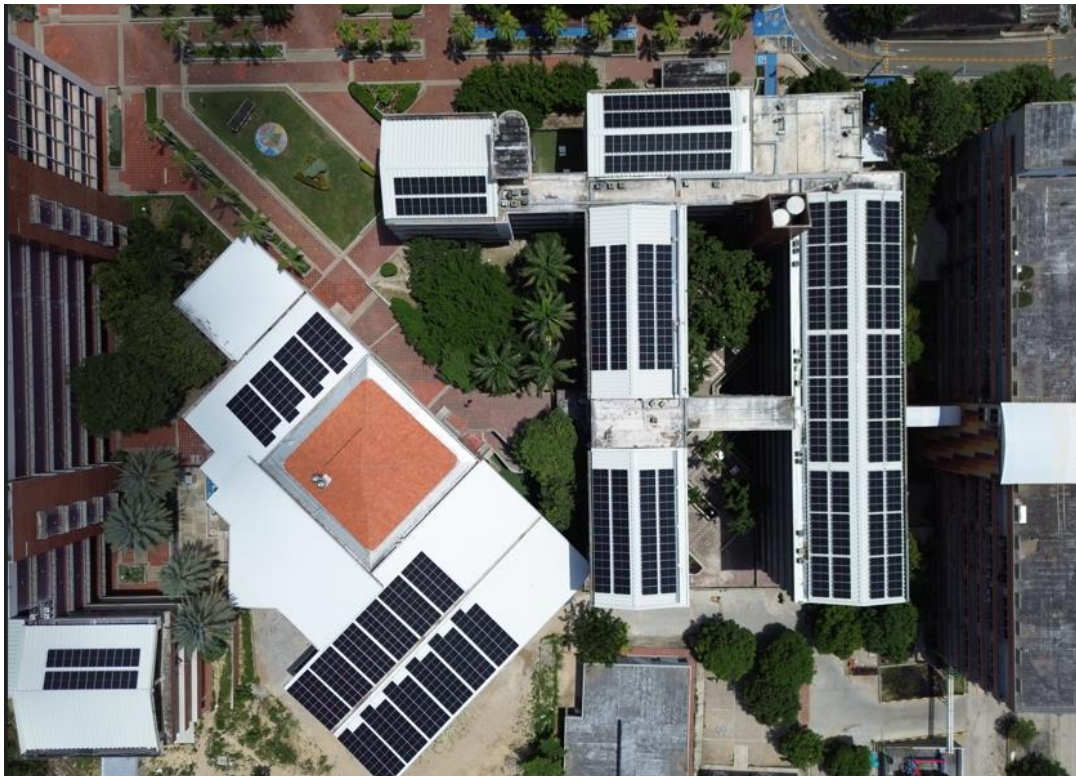
Imagen x. Paneles solares bloques I, ABC, canchas múltiples y cafetería Central.
