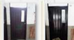
Antes Después Reparación de la pintura blanca en
