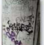
Antes Después Reparación de la pintura blanca en
