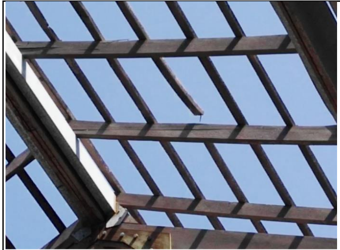
Foto No. 107 Ubicación Estructura de cubierta
