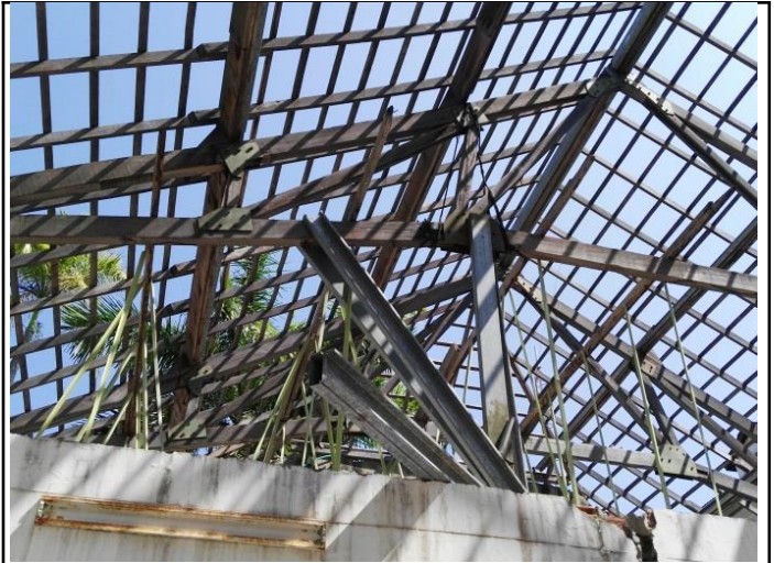
Foto No. 108 Ubicación Estructura de cubierta
