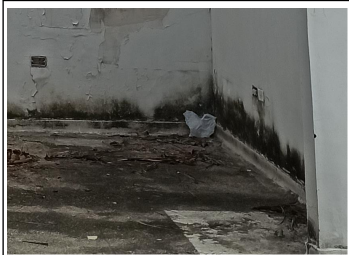
Foto No. 85 Ubicación Muro bajo Eje A con Eje 2
