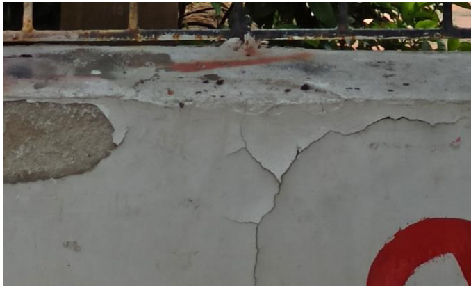
Foto No. 65 Ubicación Muro Eje A. Entre Ejes 4 y 5
