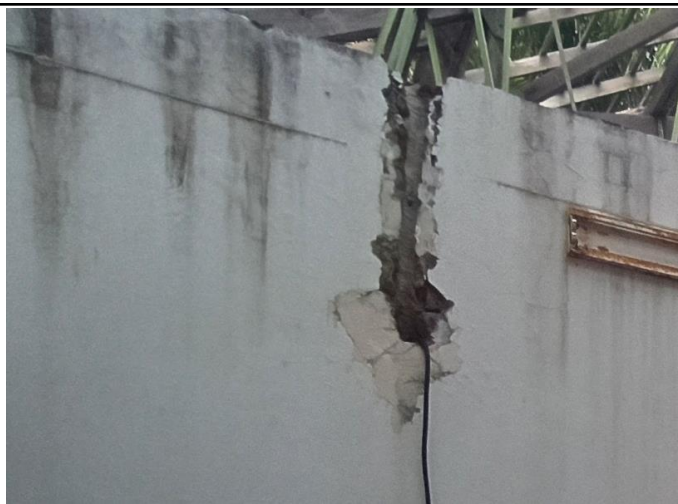
Foto No. 67 Ubicación Muro alto Eje 5. Entre Ejes A y B
