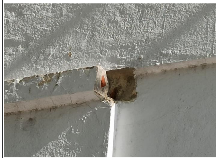
Foto No. 23 Ubicación Muro alto Eje 1 Entre ejes A y B
