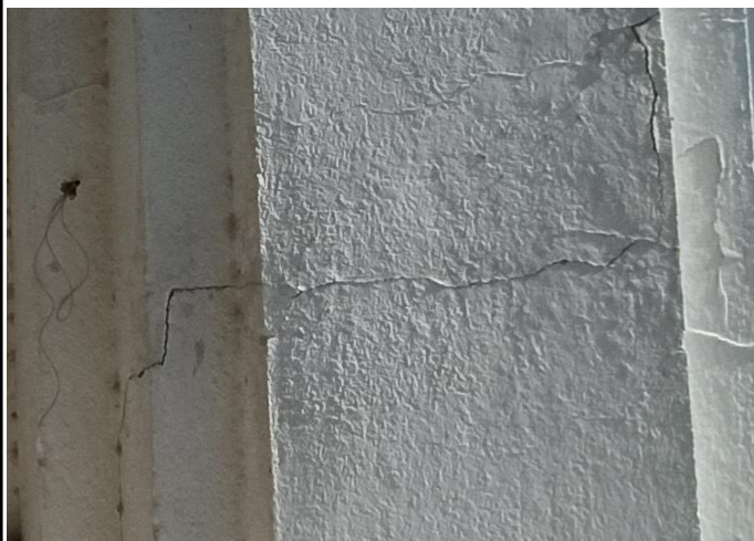
Foto No. 25 Ubicación Muro Eje 1 Entre Ejes A y B
