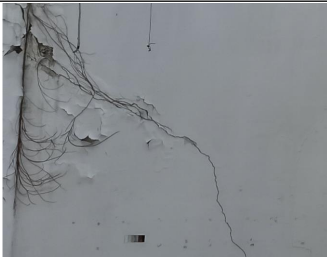
Foto No. 91 Ubicación: Muro bajo Eje 1. Entre Ejes A y B
