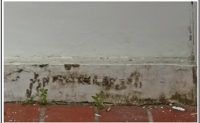
Foto No. 12 Ubicación Muro bajo Eje B. Entre Ejes 2 y 1
