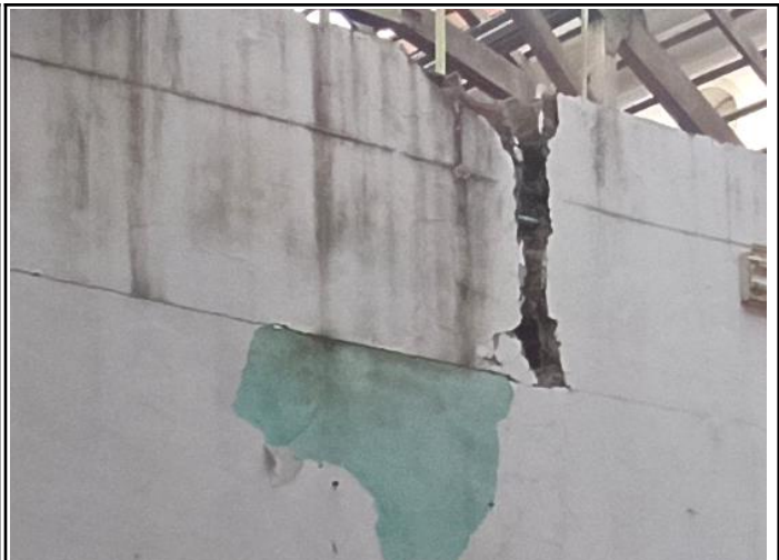
Foto No. 68 Ubicación Muro alto Eje 5. Entre Ejes A y B
