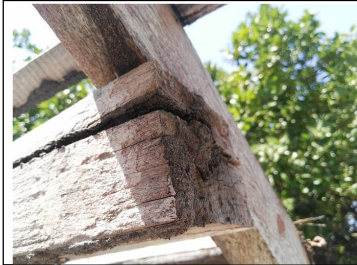
Foto No. 105 Ubicación Estructura de cubierta
