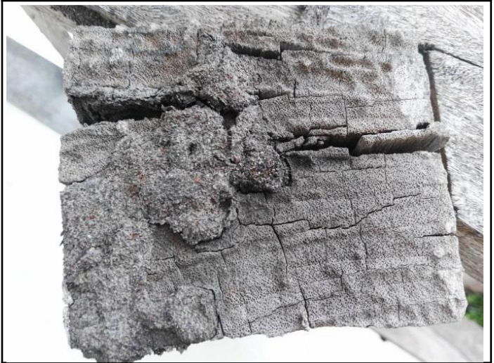
Foto No. 106 Ubicación Estructura de cubierta
