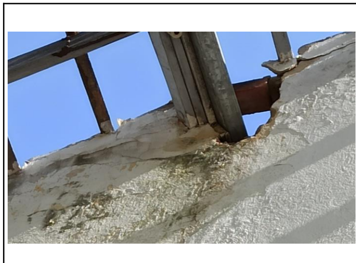
Foto No. 21 Ubicación Muro alto Eje 1 Entre Ejes A y B
