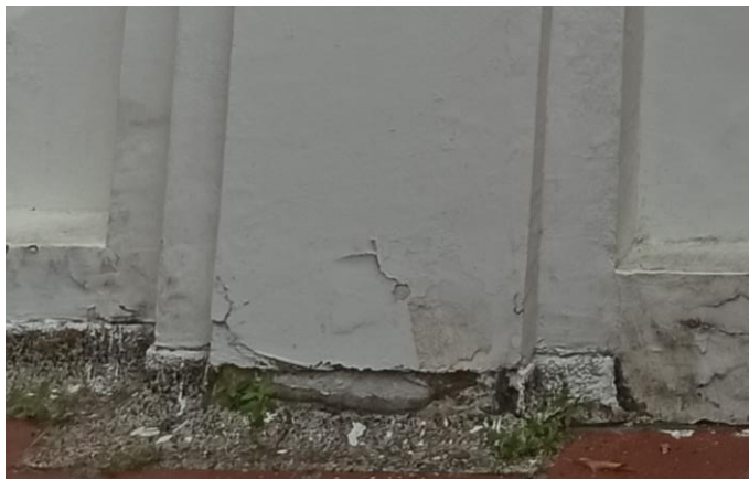
Foto No. 11 Ubicación Muro bajo Eje B. Entre Ejes 2 y 1
