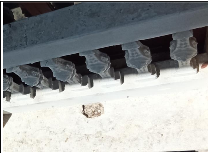
Foto No. 03 Ubicación Piso 2. Eje 6 con Eje J
