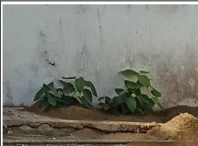
Foto No. 01 Ubicación Muro Bajo Eje 6. Entre Ejes O y N
