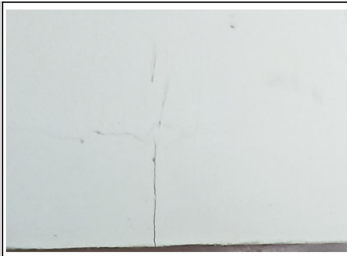
Foto No. 56 Ubicación Baño Piso 1
