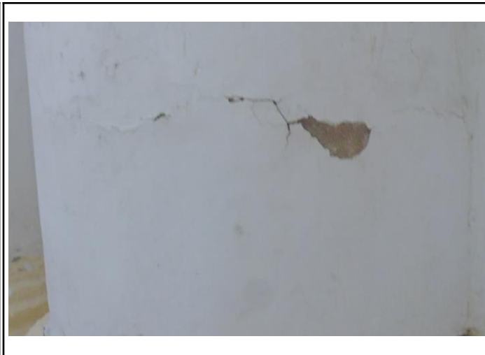
Foto No. 04 Ubicación Columna Eje 6 con Eje G
