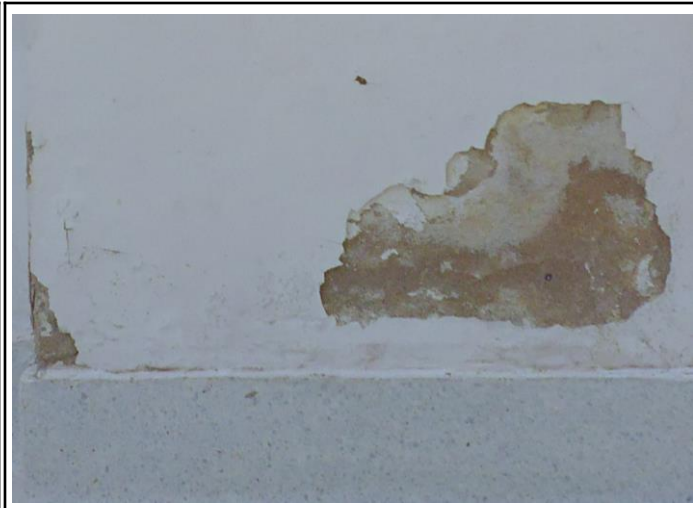
Foto No. 02 Ubicación Muro bajo Eje 6. Entre Ejes G y F
