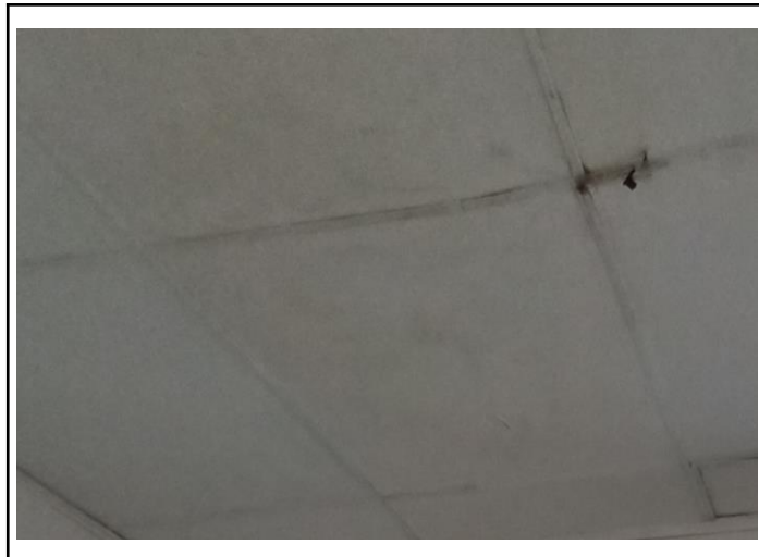
Foto No. 55 Ubicación Muro alto Eje 1. Entre ejes C y D
