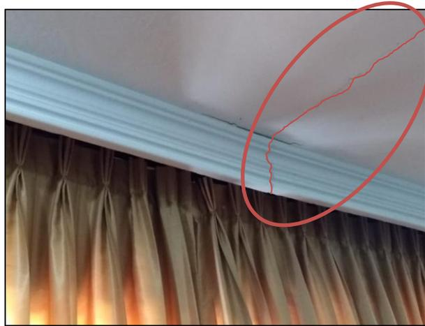
Imagen No. 75: Alfajía y losa fisurada – Bloque B4 – Museo
