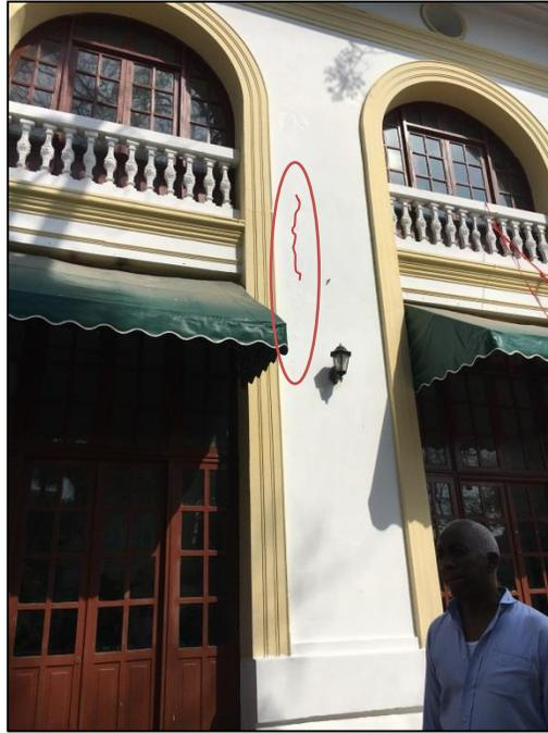
Imagen No. 66: Muro fisurado – Bloque B4 – Museo
