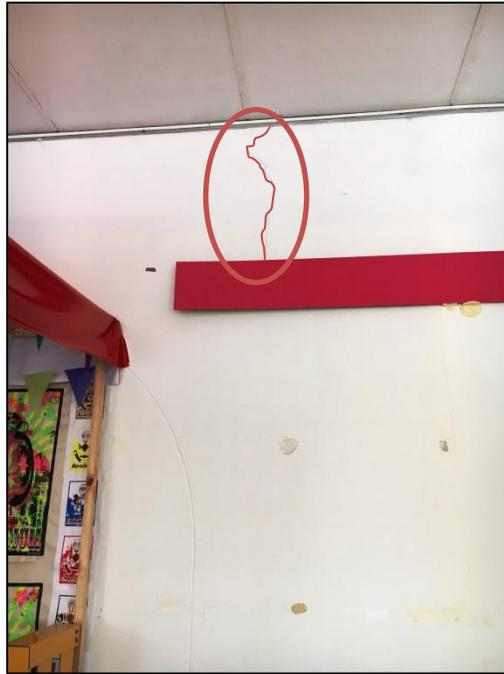
Imagen No. 70: Muro fisurado – Bloque B4 – Museo
