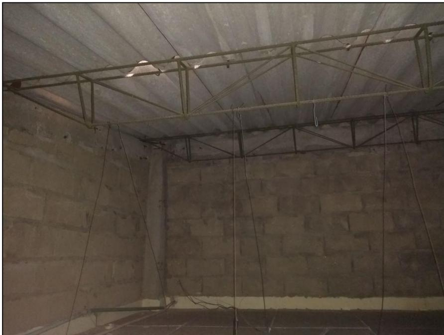
Imagen No. 112: Bloque B9 – Correas tipo joist de salones de arte dramático.
