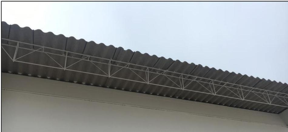
Imagen No. 16: Imagen correas cubierta bloque B9 desde el exterior
