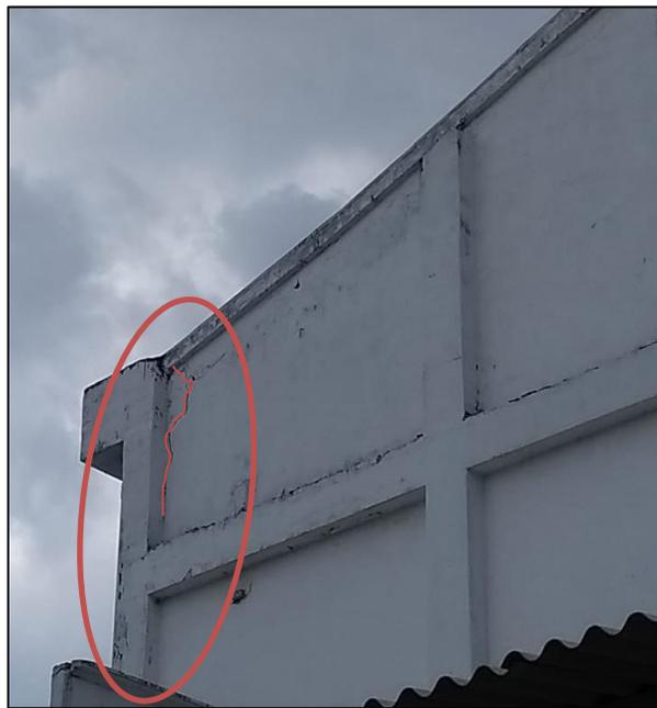
Imagen No. 27: Teatro - Zona de escenario, fisuras en el exterior – Columnas.
