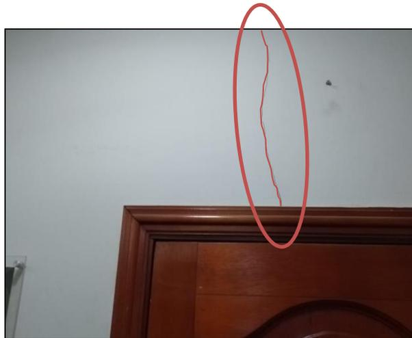
Imagen No. 73: Muro fisurado – Bloque B4 – Museo
