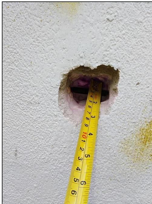
Imagen No. 115: Ensayos de carbonatación en columnas a 6 cm – Muestra #1 – Bloque B9
