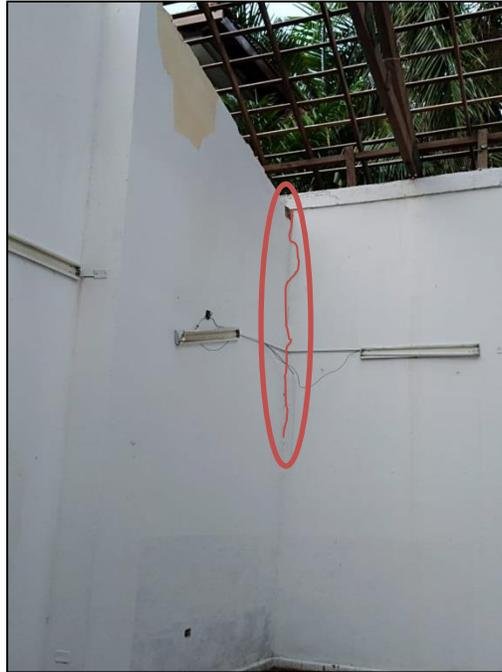
Imagen No. 86: Muros fisurados del bloque B5 – Galería
