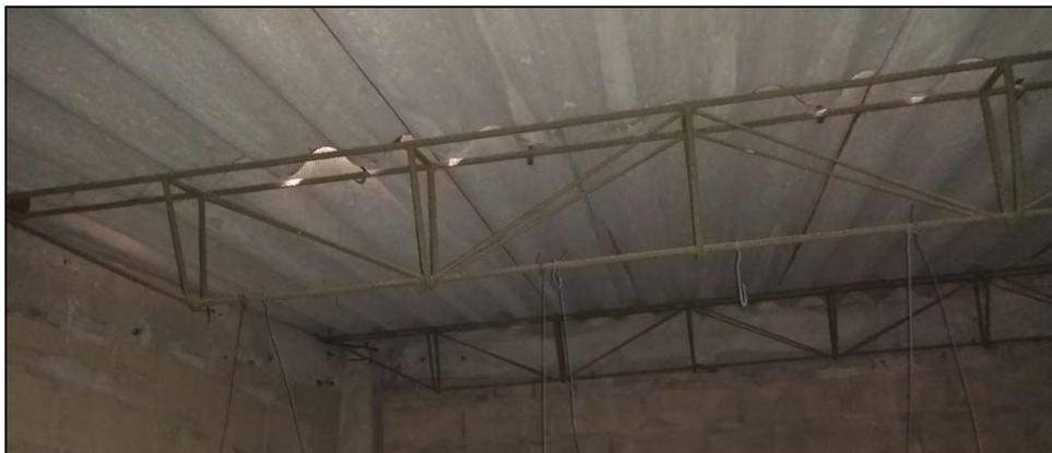
Imagen No. 17: Imagen correas cubierta bloque B9 desde el interior
