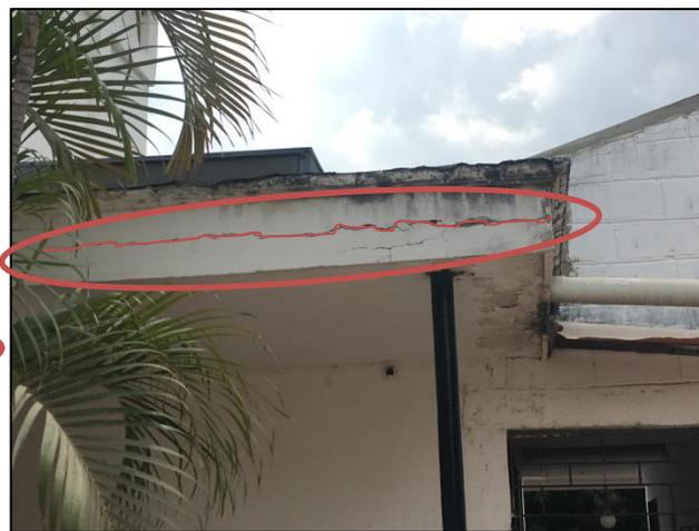
Imagen No. 25: Teatro - Zona de escenario, fisuras en el exterior – Losa del pasillo.
