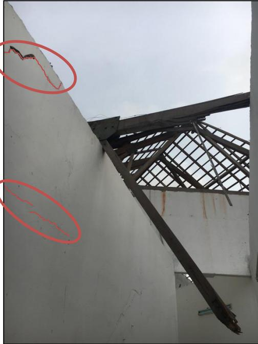
Imagen No. 56: Cubierta colapsada y muros fisurados de salones de música – Bloque B2
