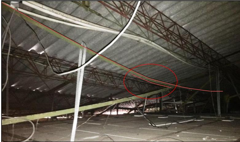
Imagen No. 31: Teatro zona cubierta platea – Elementos diagonales que conectan una cercha con la otra.
