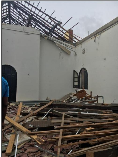
Imagen No. 61: Escombros de cubierta de bloque Pedro Biava – Bloque B3
