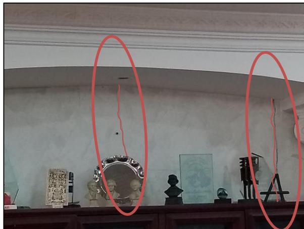
Imagen No. 74: Muro fisurado – Bloque B4 – Museo
