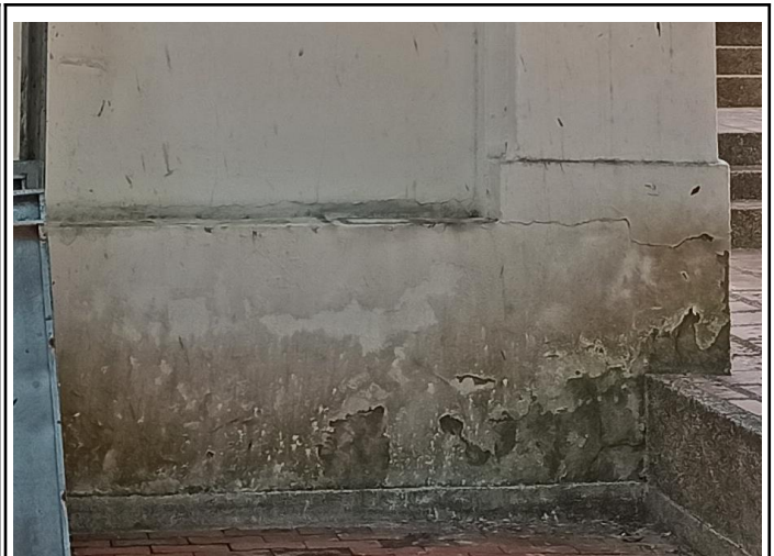
Foto No. 16 Ubicación Muro bajo. Ejes 3 y 4
