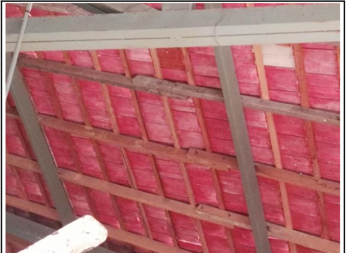
Foto No. 44 Ubicación Estructura de cubierta
