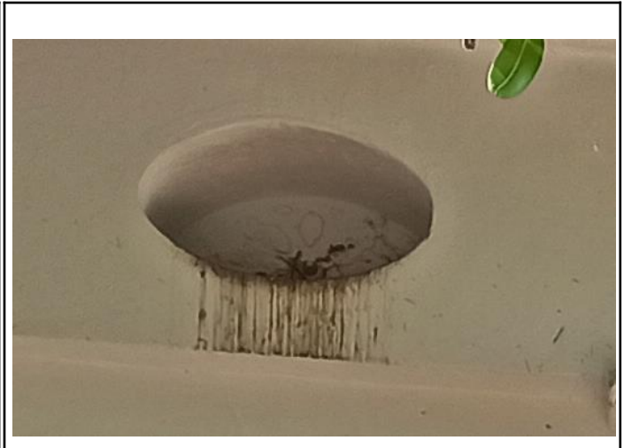
Foto No. 14 Ubicación Ventana. Ejes 3 y 4.
