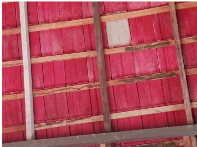
Foto No. 41 Ubicación Estructura de cubierta
