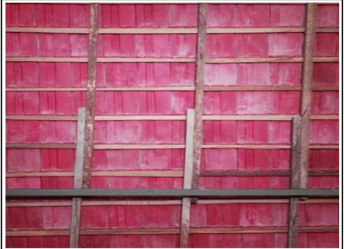
Foto No. 42 Ubicación Estructura de cubierta
