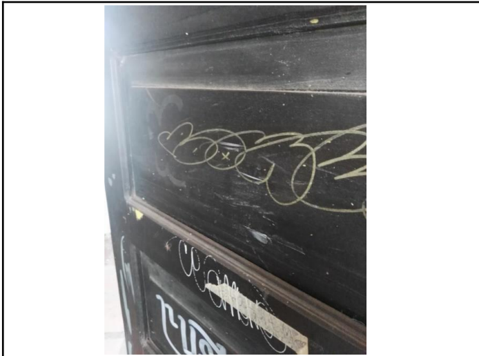
Foto No. 45 Ubicación Puerta Aula 4
