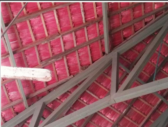
Foto No. 43 Ubicación Estructura de cubierta
