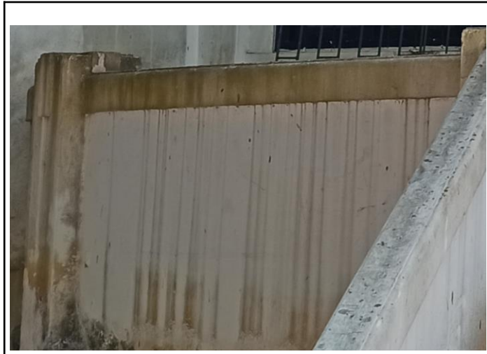
Foto No. 13 Ubicación Muro bajo. Ejes 2 y 3.
