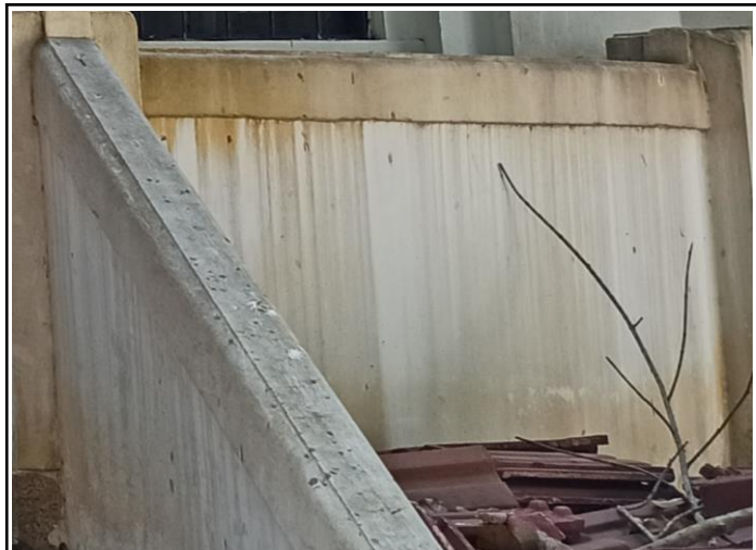
Foto No. 15 Ubicación Muro bajo. Ejes 3 y 4
