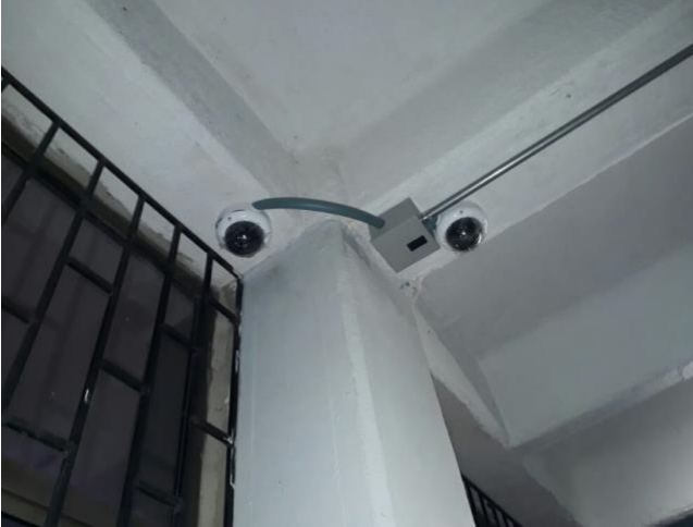
Figura. Cámaras de seguridad
